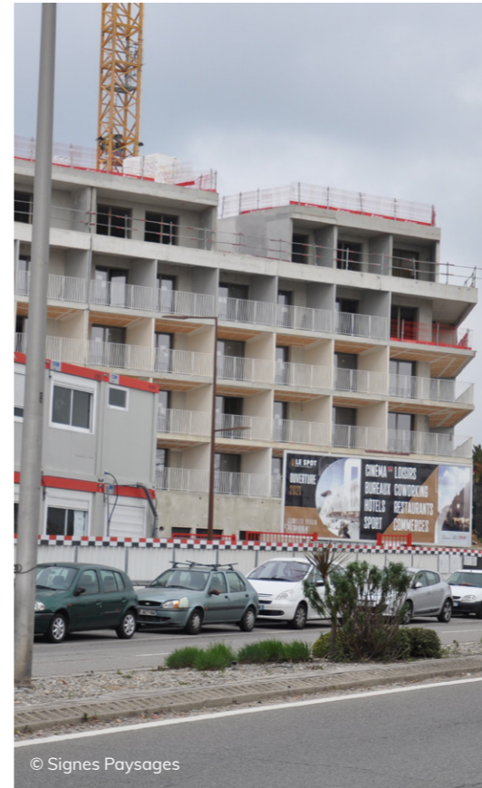
De nouveaux lieux en construction en entrée de La Ciotat
