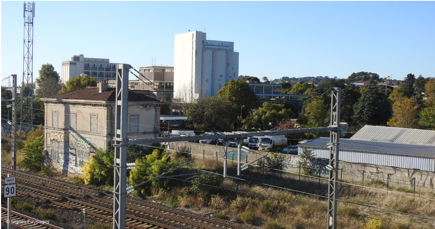
La vallée de l'Huveaune industrielle, usine à Saint-Menet
