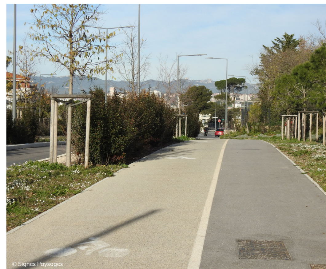
Le Boulevard Urbain Sud à Saint-Tronc, l'occasion de mobilités douces dans la ville et de TCSP (Transports en Commun en Site Propre)
