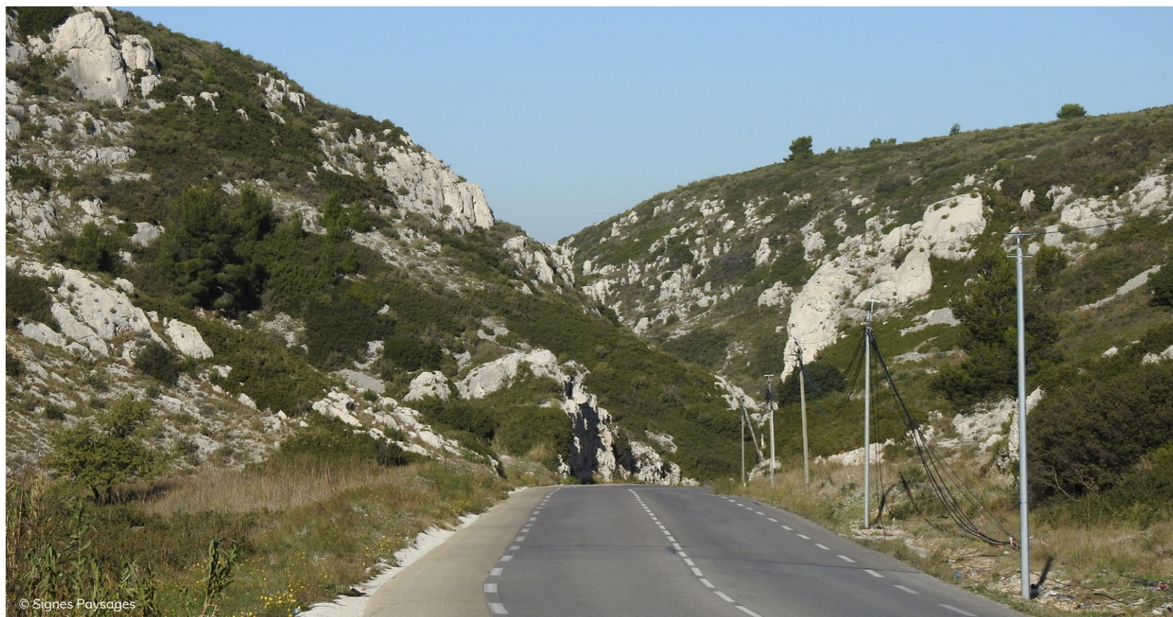
Le vallon du Douard parcouru par la RD568
