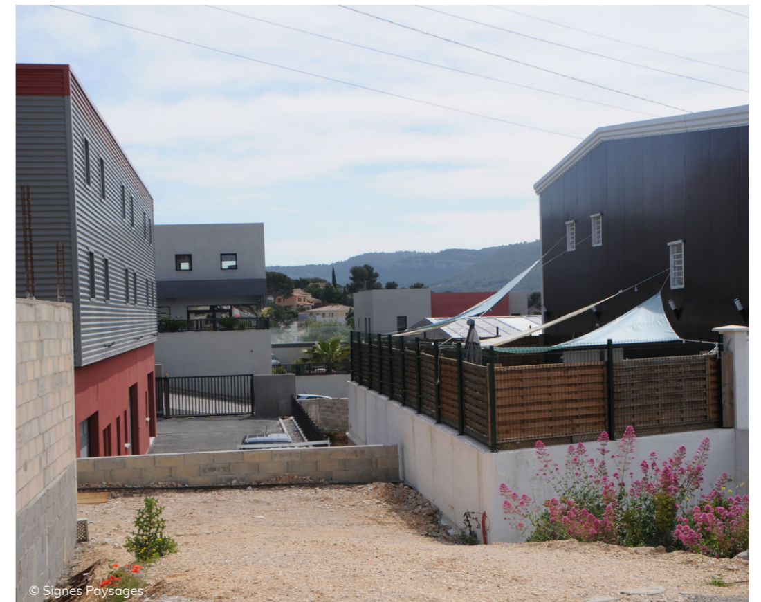
Imbrication des volumes bâtis et imperméabilisation des sols
