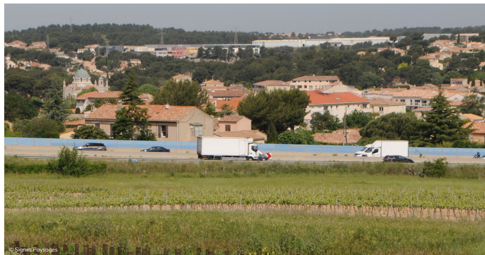
Les bâtiments des activités se distinguent par leurs dimensions monumentales pour certains au milieu de l'habitat pavillonnaire et des pinèdes résiduelles en milieu urbain
