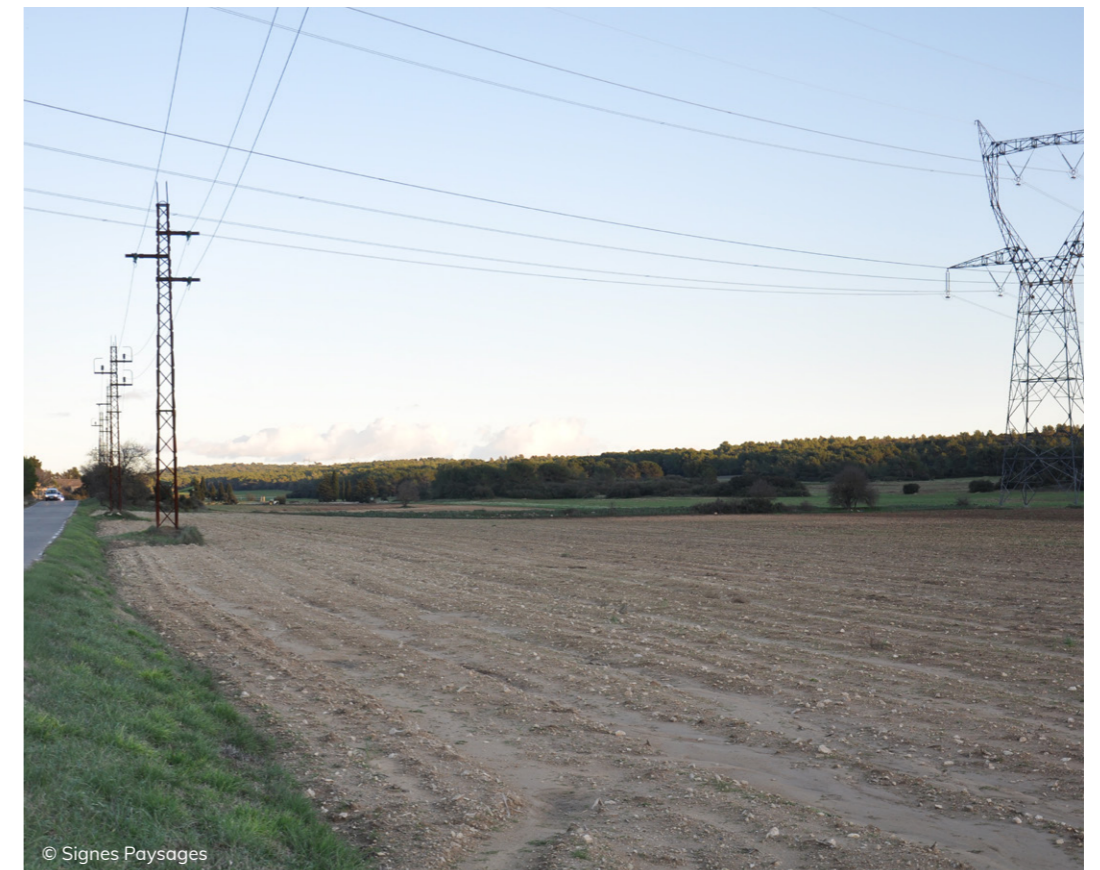
Des infrastructures énergétiques dans les vallons
