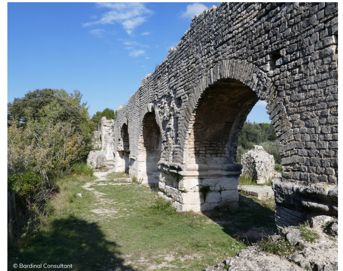
L'aqueduc romain de Barbegal
