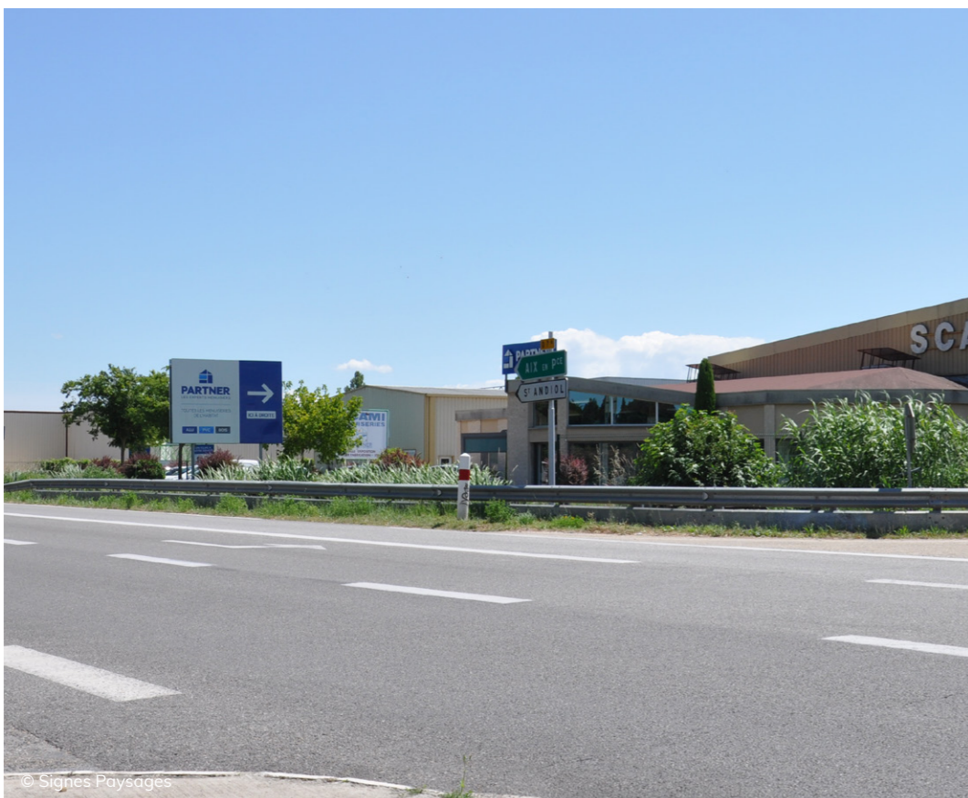
Une zone d'activités le long de la RD7N à Eyrargues
