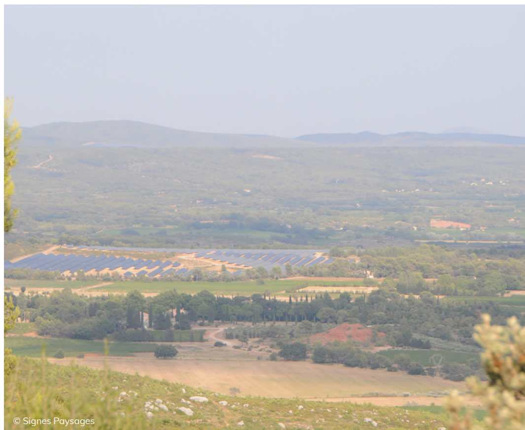
Sur l'ancien site de Richaume, une ferme photovoltaïque a remplacé les activités d'extraction
