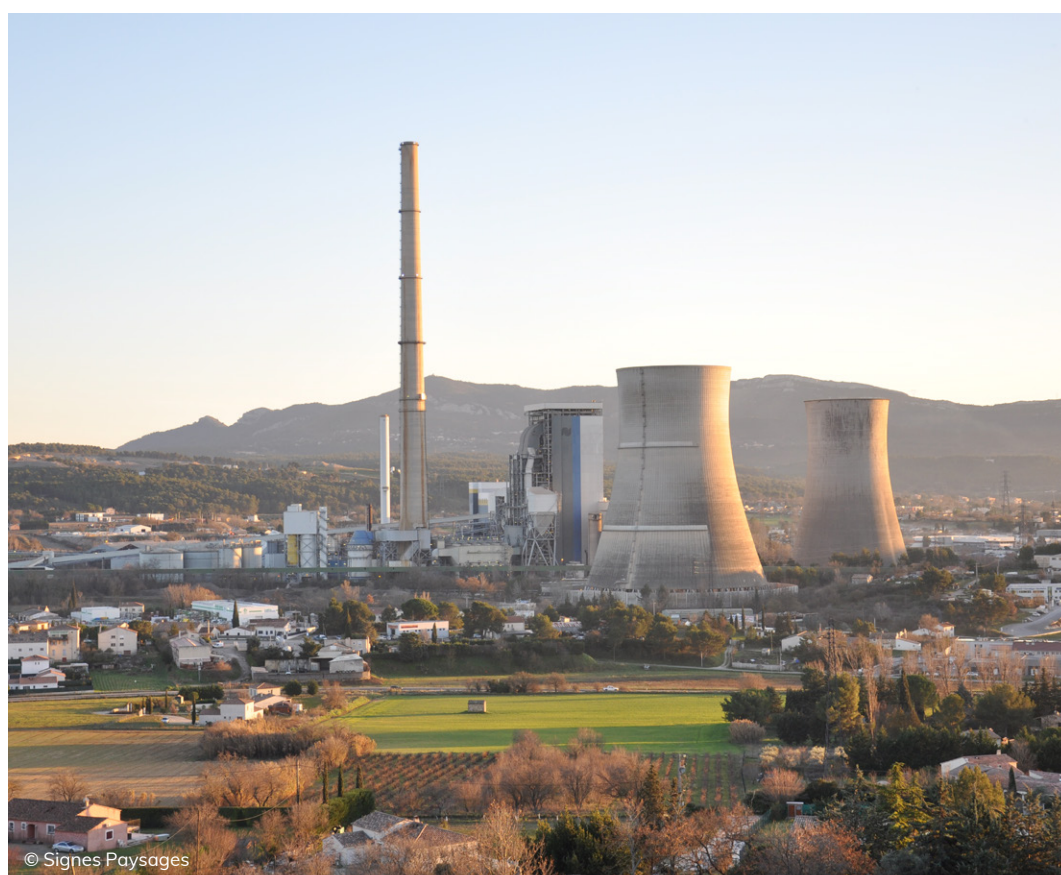
La centrale thermique de Gardanne
