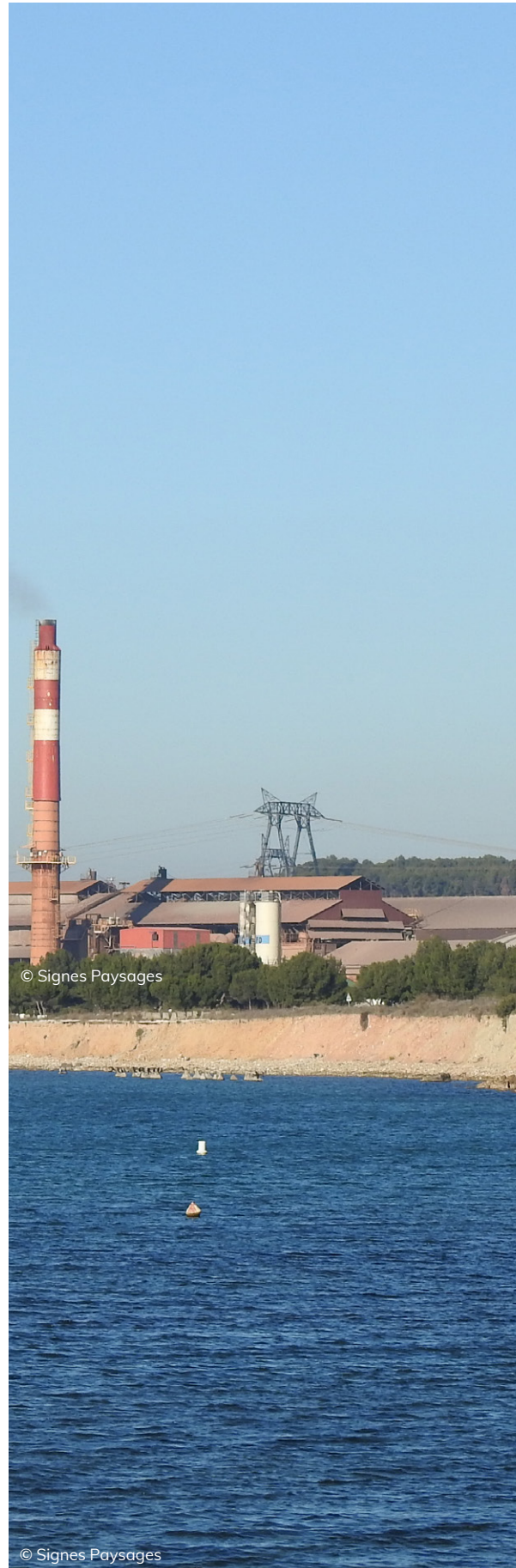
L'usine d'aluminate de Port-de-Bouc
