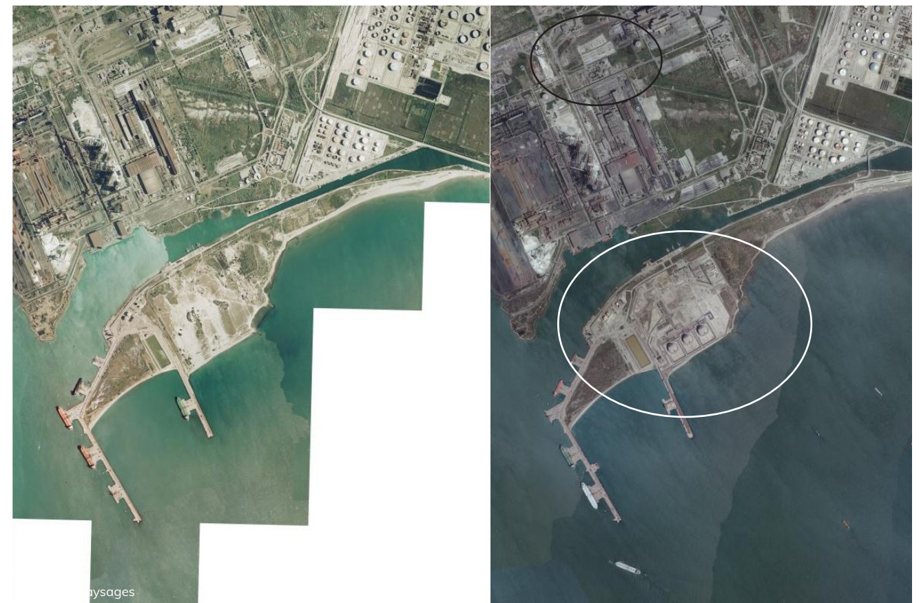
Construction du terminal méthanier de Fos-Cavaou en 2010 (photos aériennes 2005 et 2019)
