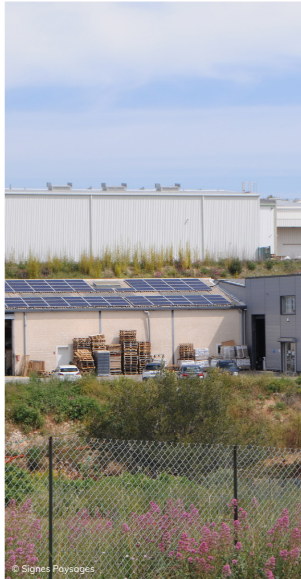
Panneaux photovoltaïques en toiture d'un entrepôt
