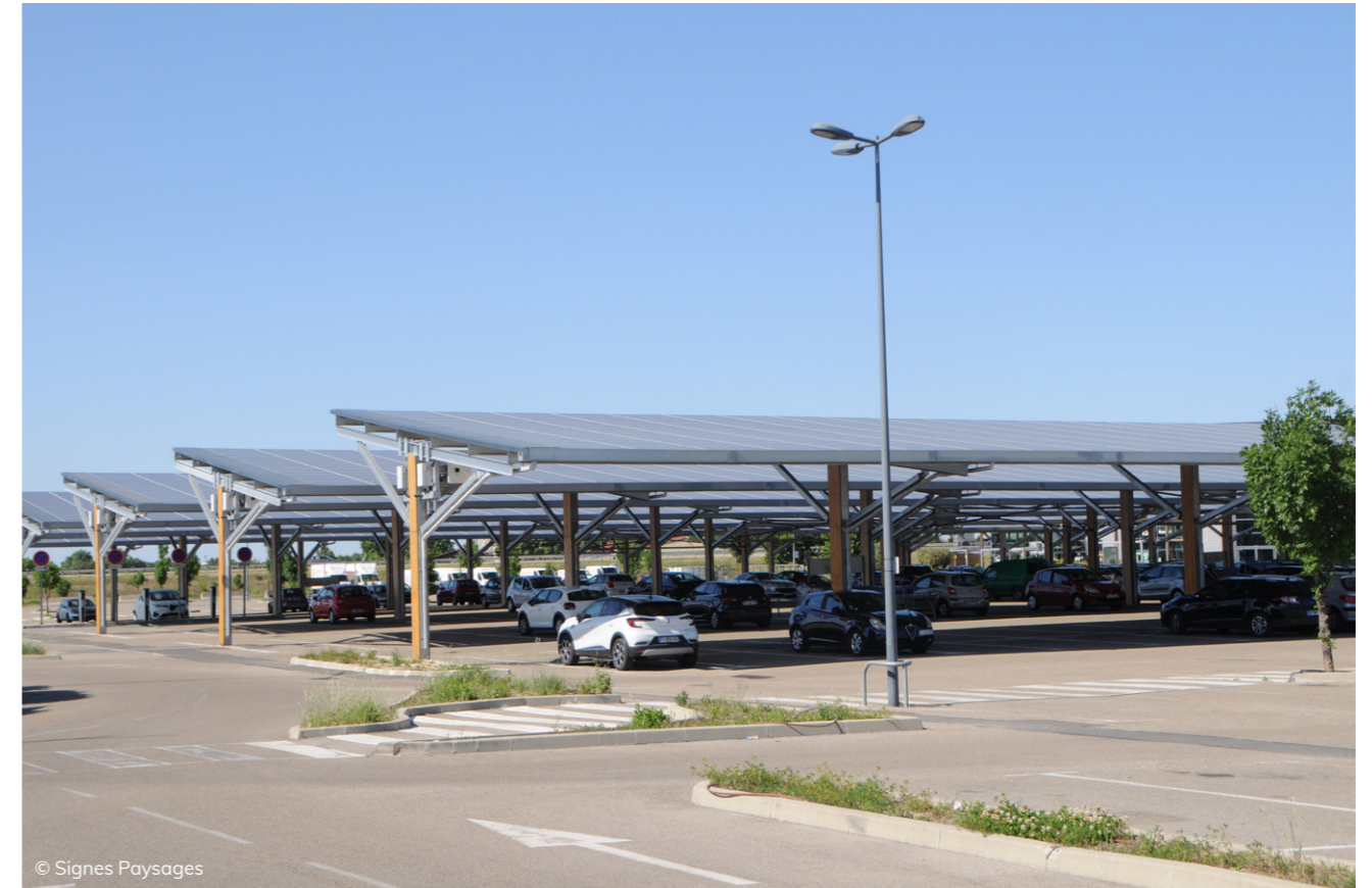
Panneaux photovoltaïques implantés sur les ombrières d'un parking de surface commerciale
