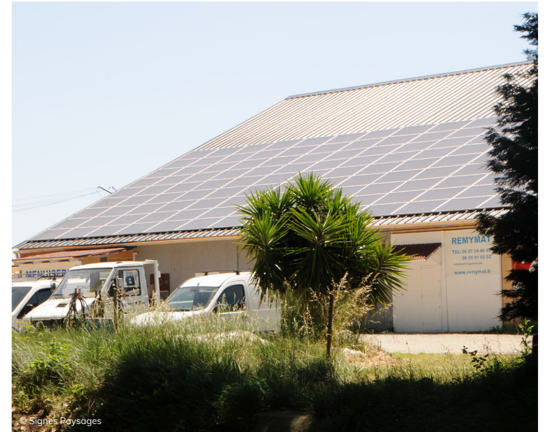
Panneaux photovoltaïques en toiture d'un entrepôt
