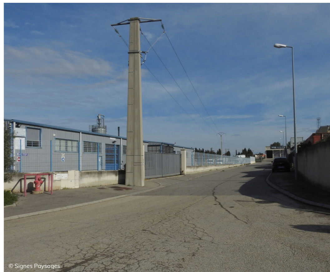
Une succession de hangars métalliques
