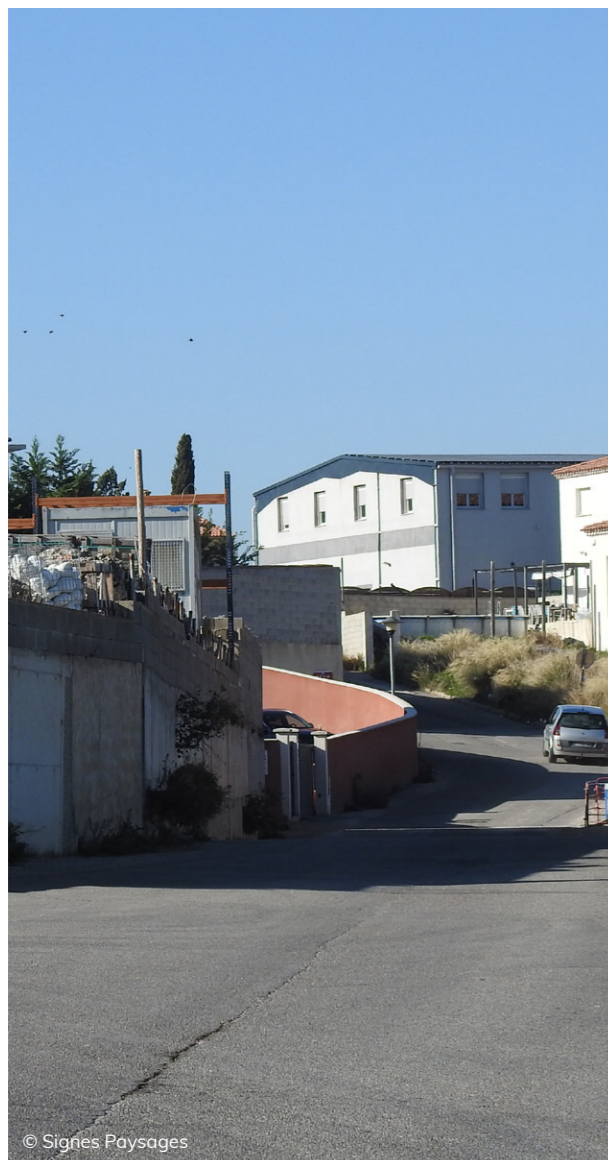
Des bâtis techniques et d'habitat rassemblés sur la ZA du Rove
